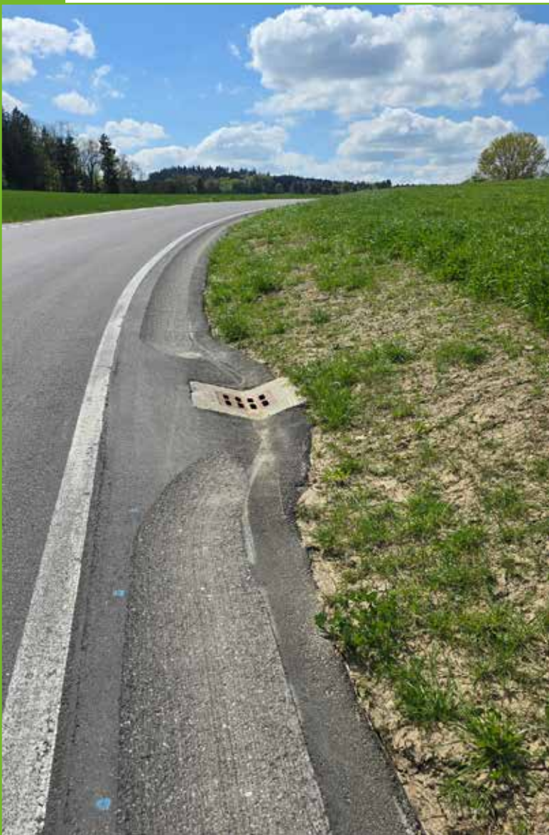
Belagsrigole an der Niesenbergstrasse
